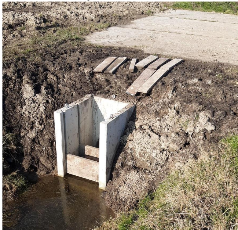
Figuur 4.2: Zoete stuw met rubberen flappen.
