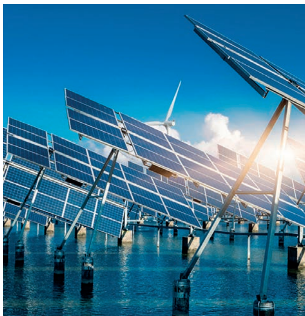
Zonnepanelen op water
